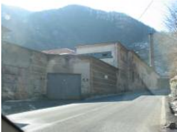
Foto.2: Ex produttivo ora in parte deposito Provinciale
